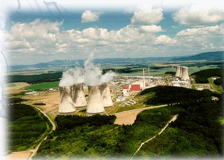
АЭС «Моховце», Словакия
